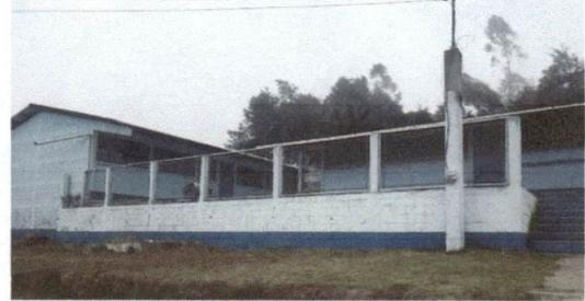
Foto 2: Reparacion de muro perimetral de malla vieja por malla nueva galvanizada 16.20 metros lineales con una altura de 1.50 metros.
