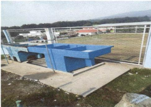
Foto 3: Sustitucion de pila de cemento de 2 lavaderos
