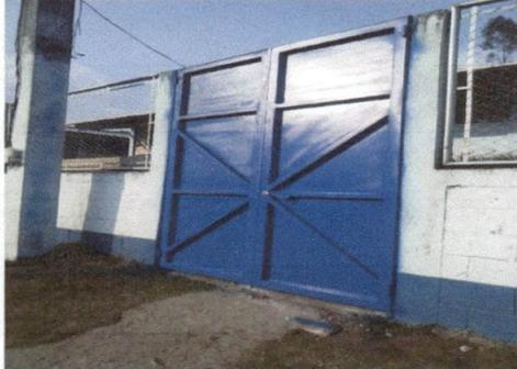
Foto1: Cambio de pórton de malla por portón de estructura metáltica a doble hoja con dos columnas de concreto armado.
